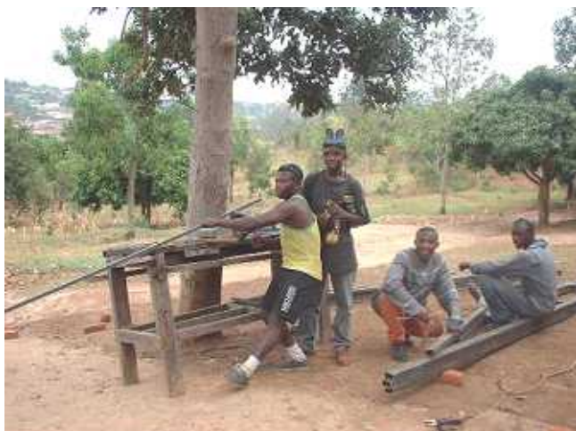
屋根になる鉄板を取り付ける為の溶接作業
