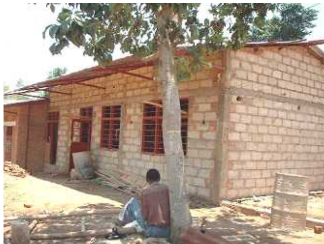
屋根取り付け後の教室外観
